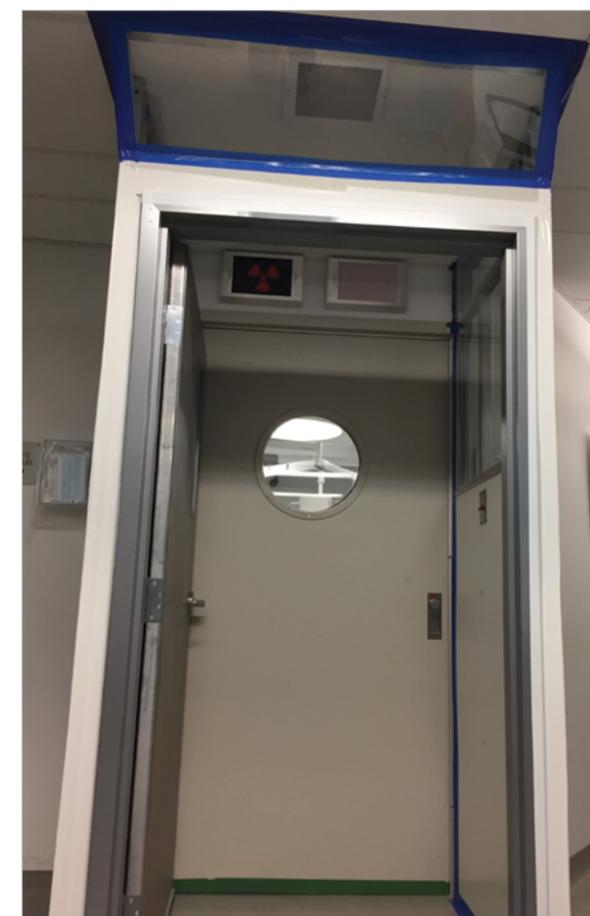
**Figure 4 :** Enceinte du SAS vue de face, porte extérieure ouverte
